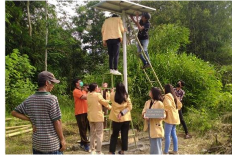
Gambar 6. Pemasangan Komponen Panel
