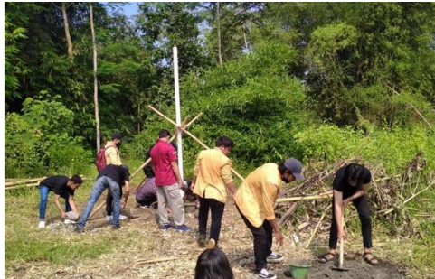
Gambar 5. Pemasangan Struktur penopang
