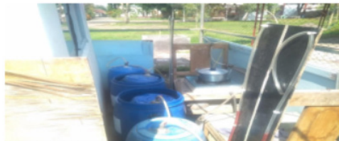
Gambar. 5.1 Intalasi biogas skala kecil
